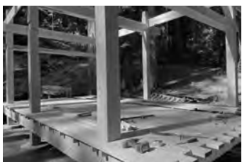
建設中の礼法スタジオ
